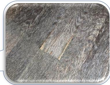
床が反ったり剥がれた(剥離)箇所にヤスリをかけて(研磨)全てを平らにします。その後掃除(水拭き等)を行ない、最後にワックスをかけます。
